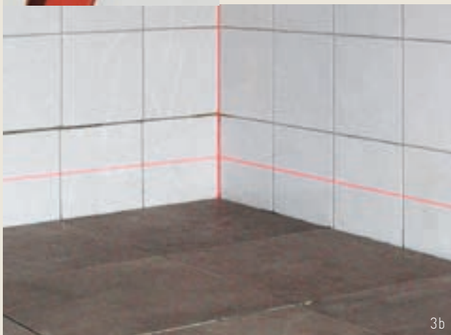
Figur 3a og b: Laser benyttes for å måle høyder eller etterkontrollere fall
